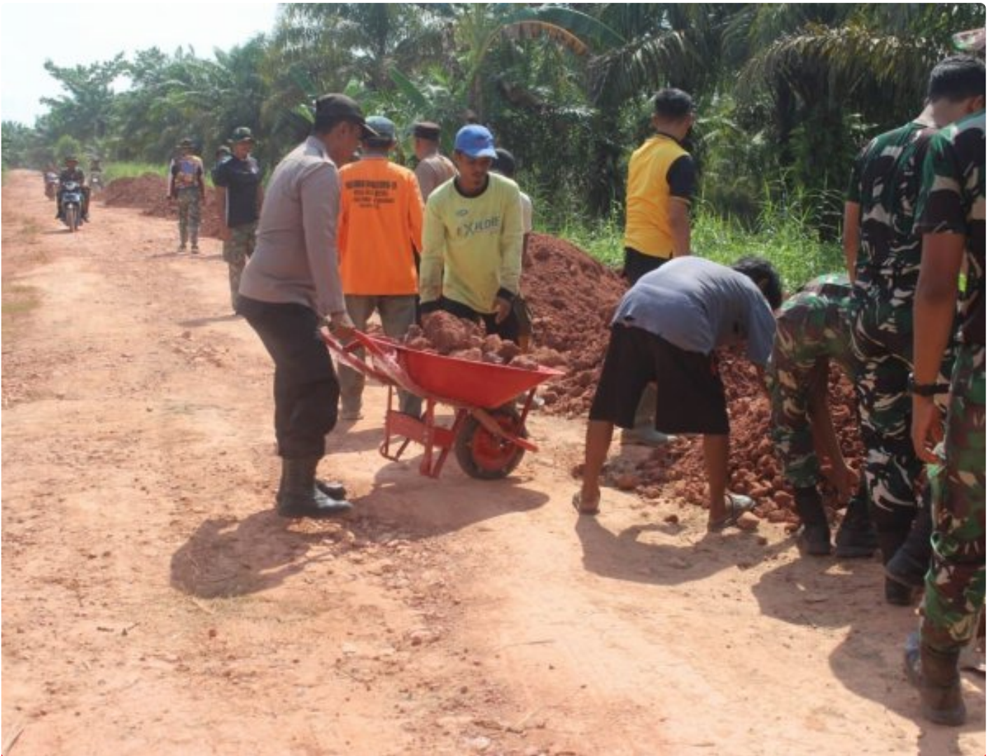
Personel Satgas TMMD Bahu Membahu Mengerjakan Sasaran Fisik Peningkatan Jalan
